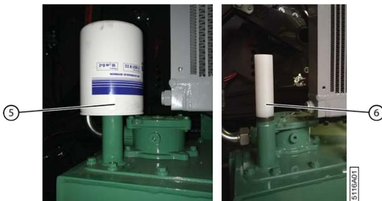
Fig. 16: Purgeur et dispositif anti-déversement
